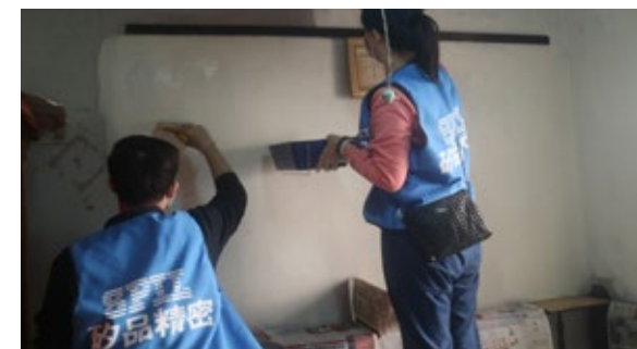
弱勢關懷房屋修繕
