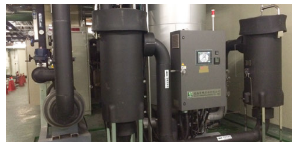
日月光半導體中壢廠 - 使用外熱式空壓機
